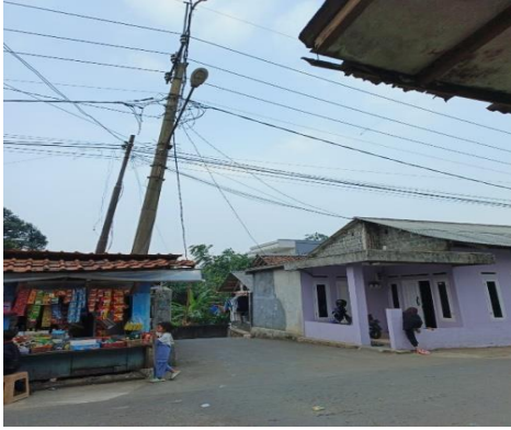
Lokasi Pemasangan CCTV di Rw 5
