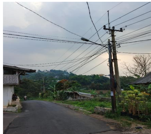
Lokasi Pemasangan CCTV di Rw 4
