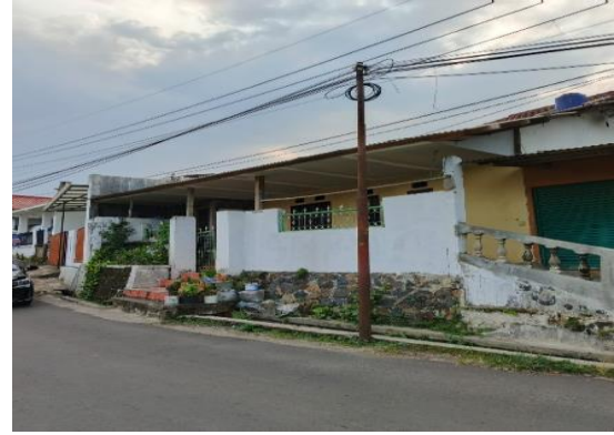
Lokasi Pemasangan CCTV di Rw 6
