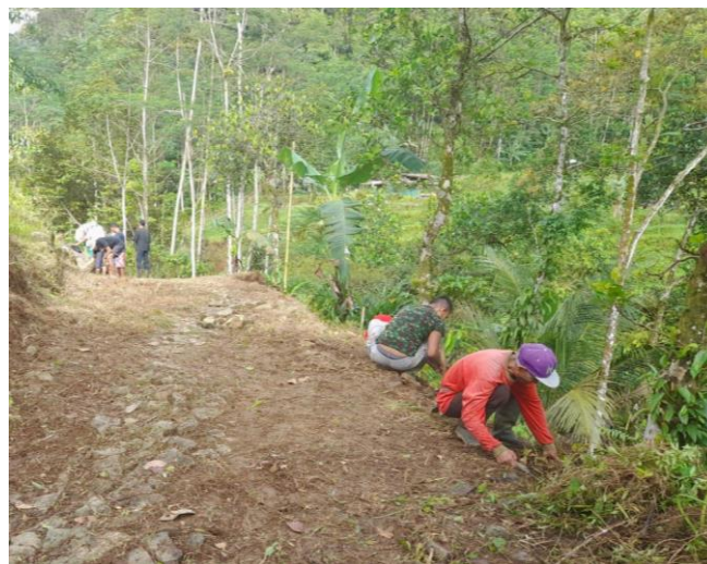
Gambar 5. Proses Persiapan Pembangunan Jalan
