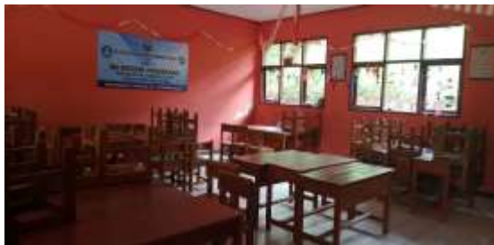
Gambar 1 Kondisi Ruang Kelas V)
